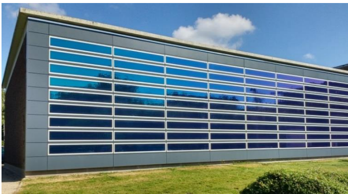
Solar aktive Fassade mit HeliaFilm ® bei ENGIE Laborelec, Linkebeek, Belgien
